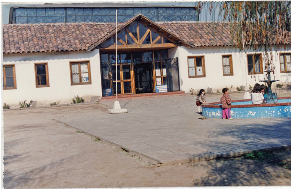
el antiguo invernadero; al interior: estructura metálica y cúpula de vidrio.
